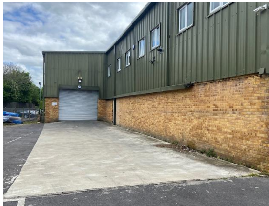
Roller shutter loading door
